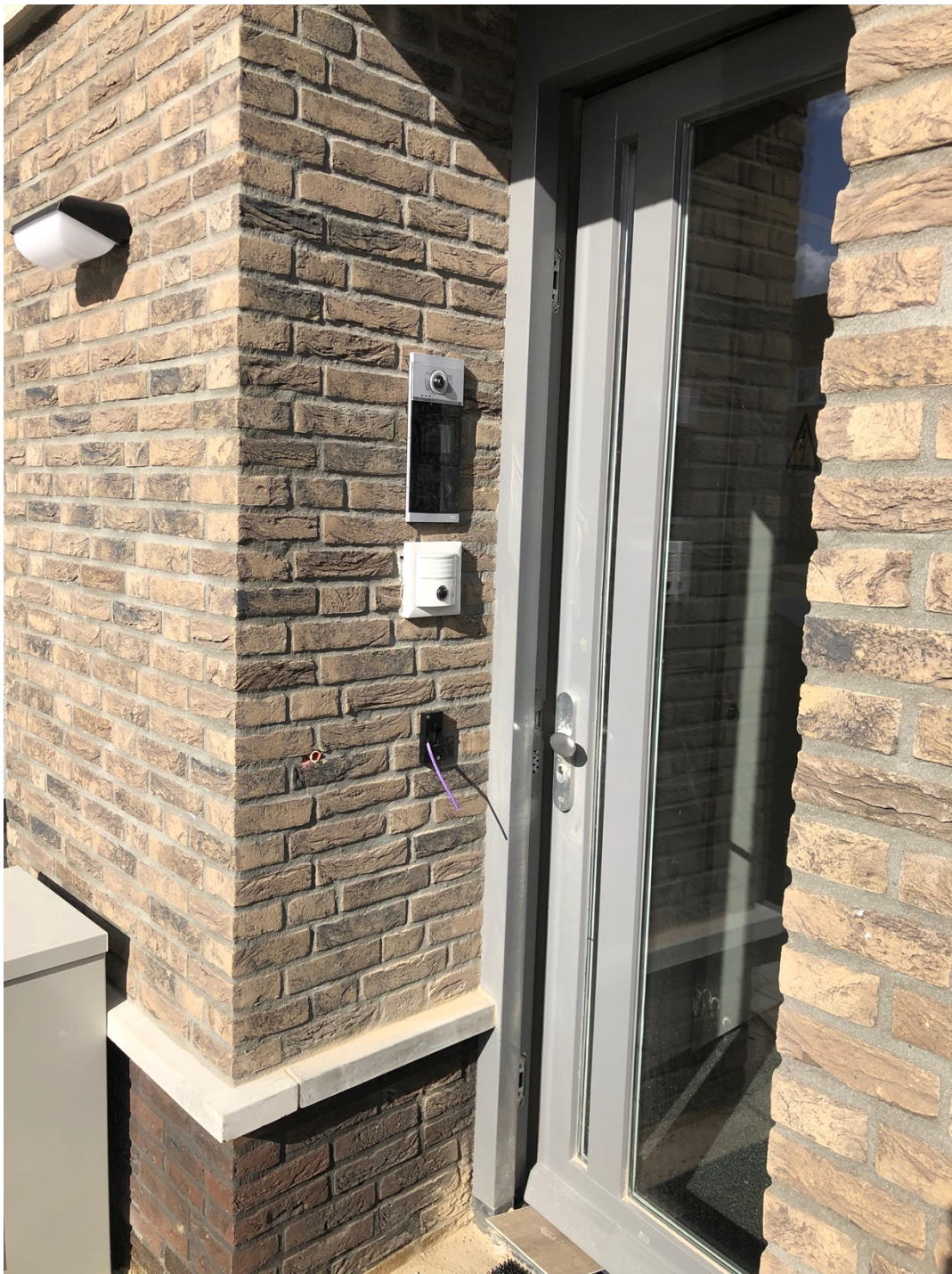
11. afbeelding video-deurcommunicatie systeem entree deur gebouw
